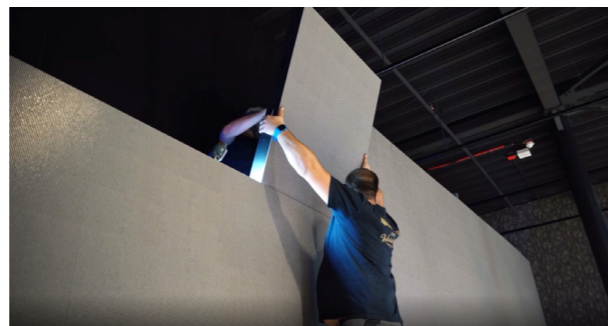
Die LED-Wand wird aus einzelnen Modulen zusammengesetzt, die dann als eine Einheit arbeiten.
